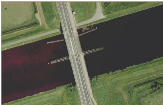
Figuur 4.4: Bovenaanzicht Eelwerderbrug (bron: Google)
