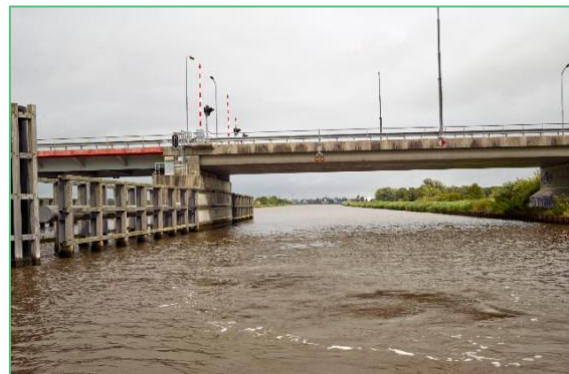
Figuur 4.3: Vaste deel Eelwerderbrug (bron: RWS Noord Nederland)
